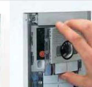
3 Solte as presilhas e retire a placa frontal.
